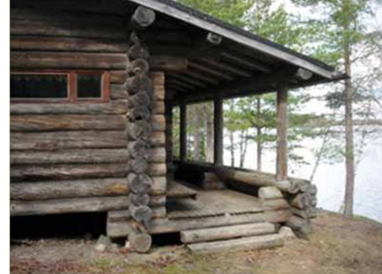
Taidokasta hirsirakentamista ulkona ja sisällä.
